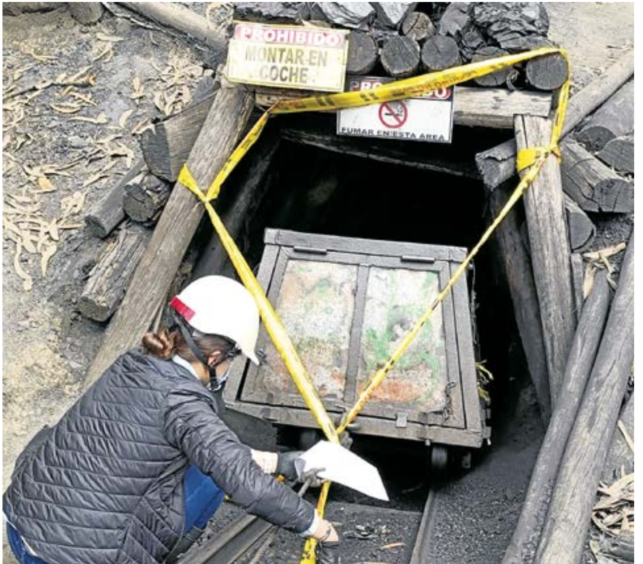
De igual manera, fueron identificados vertimientos de combustibles sin tratamiento en zonas destinadas a talleres y malacates, cuyos pisos se encuentran en tierra. A. Particular.
