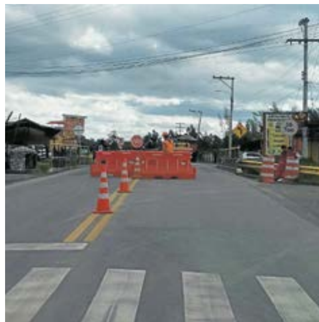
Trabajos de mantenimiento en 'Puente del río' vía a Chiquinquirá. Archivo particular.
