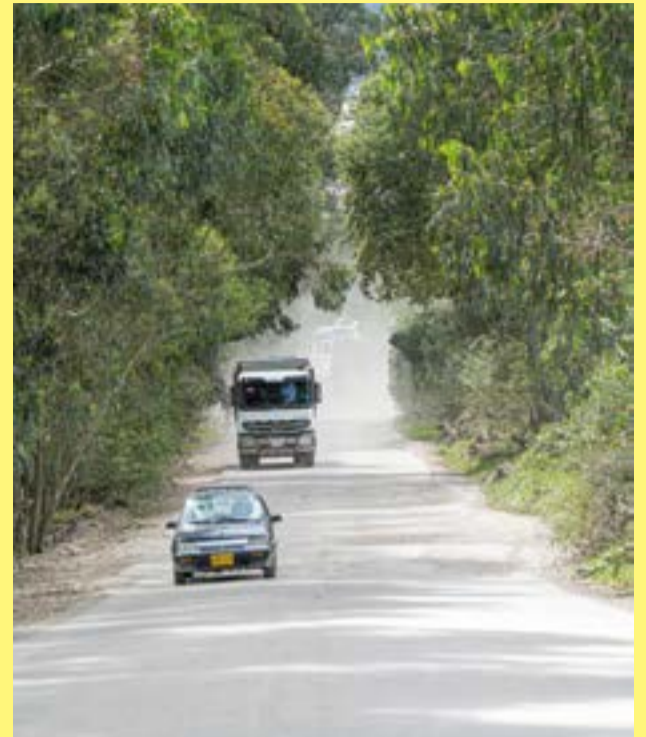
Se contempla la intervención de 4,2 kilómetros mediante obras de pavimentación.
