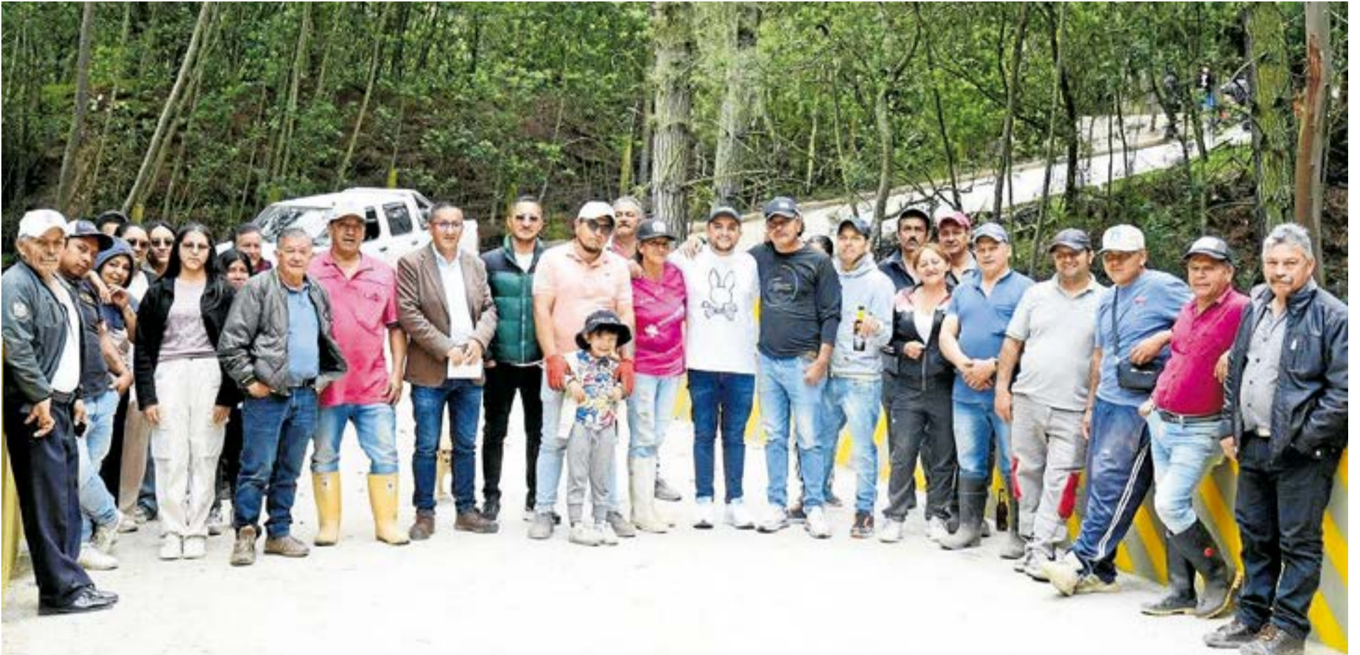
La Administración Municipal informó la entrada en funcionamiento de esta obra de infraestructura vial, que busca facilitar el tránsito de habitantes, estudiantes, productores y vehículos que se movilizan por esta zona rural de Sutatausa. Fotos: Alcaldía de Sutatausa.
