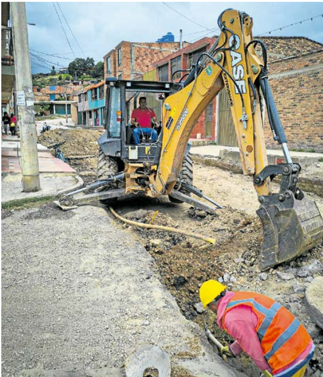
Actualmente avanzan las excavaciones y el cambio de redes en este acceso vial de Ubaté, donde la administración municipal proyecta concluir las obras y habilitar el tránsito. AP
