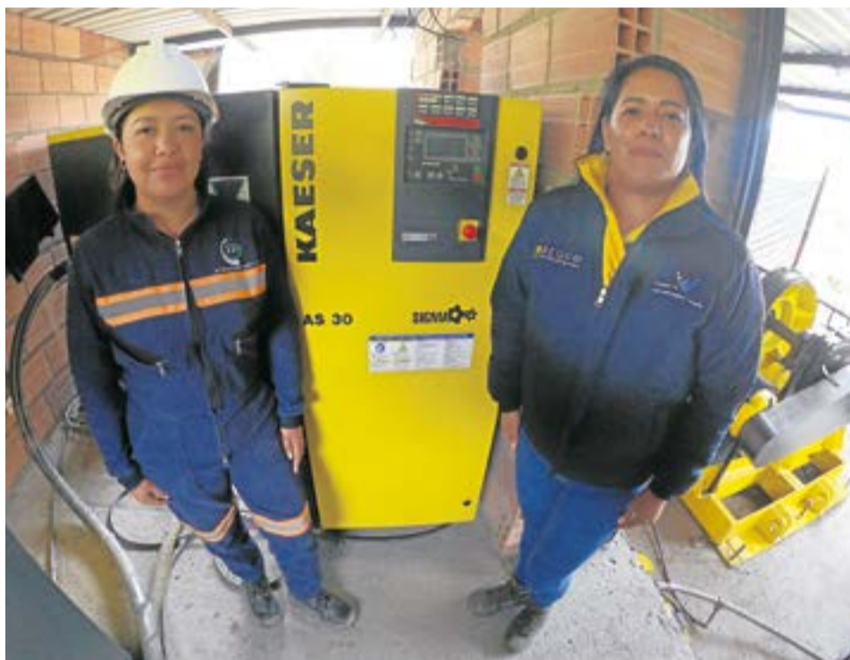
Sobre su experiencia Begom, indican que ha sido satisfactoria, sobre todo en todo el proceso de respaldo y seguimiento. La Villa
