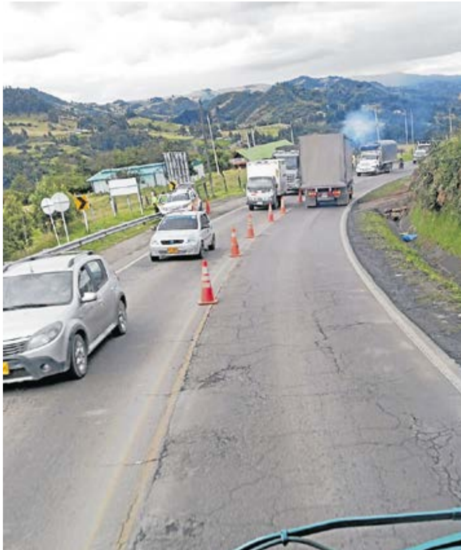
Mientras se continúa con esta discusión, los accidentes no paran y la vía se sigue deteriorando. Archivo particular.
